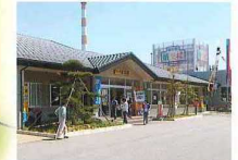
●海の駅 壺気楼 Utsunomiya Station
