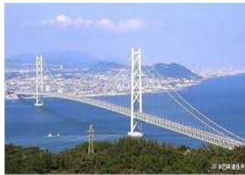
明石海峡大橋
