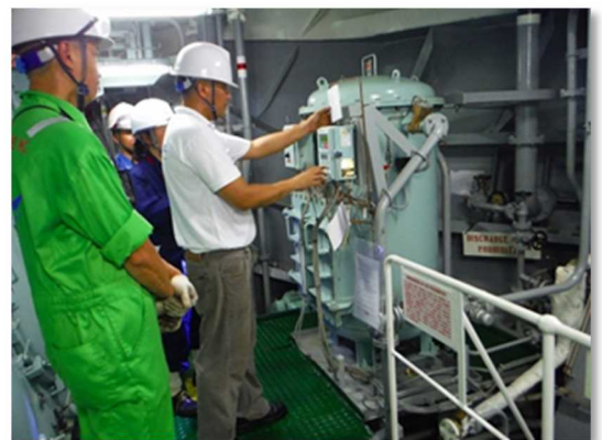
油水分離器の検査
