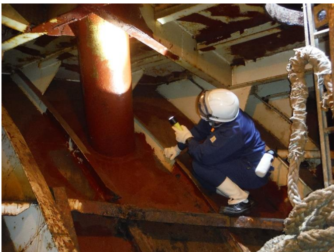
錨鎖孔(ホースパイプ)の検査
