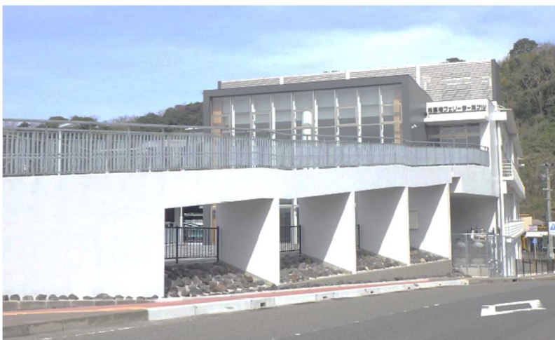
平成30年3月19日から共用開始された、鹿児島市船舶局 桜島ターミナル。ターミナル内から船舶の乗船口までバリアフリー化され、施設利用者の利便性が格段に向上した。
