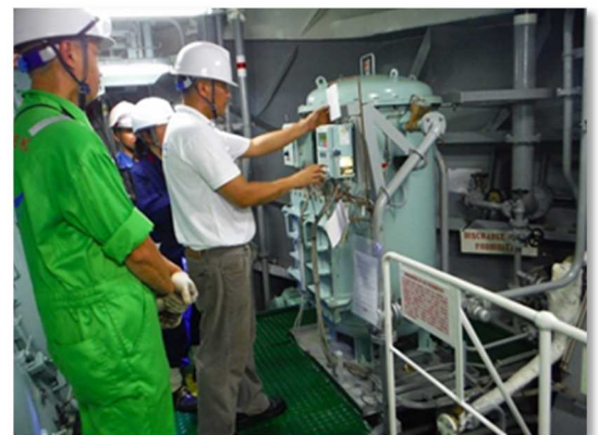
油水分离器の検査
