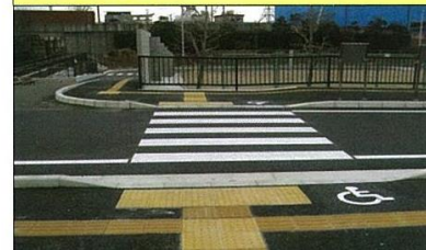
② 縁石の段差
