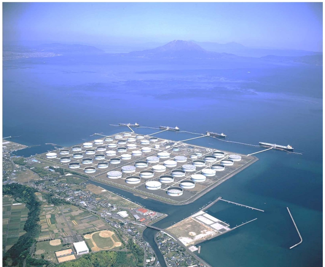
735万キロリットルの原油貯油能力を有する「JX喜入石油基地」。中東をはじめとする産油国から30万DW級の大型タンカーで輸送されてくる原油を一旦荷揚げし、10万DW級のタンカーに積み替えて他の製油所へ二次輸送する中継機能を有している。(写真提供: JX喜入石油基地株式会社)
