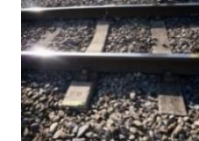
線路設備の修繕
