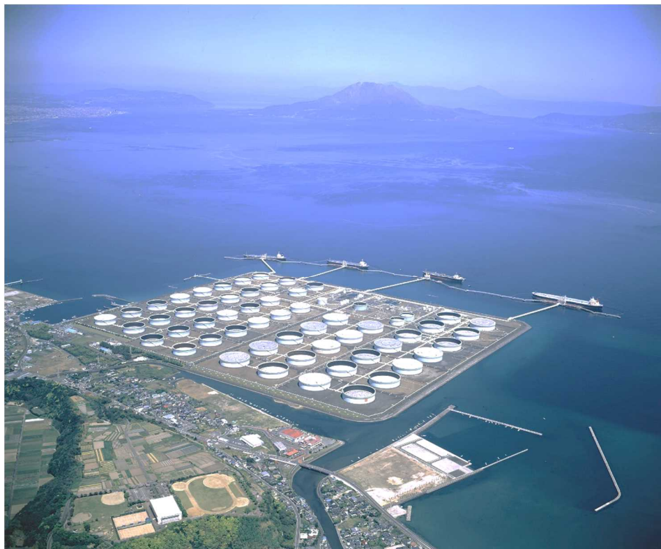
735 万キロリットルの原油貯油能力を有する「ENEOS 喜入石油基地」。中東をはじめとする産油国から 30 万DW級の大型タンカーで輸送されてくる原油を一旦荷揚げし、10 万DW級のタンカーに積み替えて他の製油所へ二次輸送する中継機能を有している。(写真提供:ENEOS 喜入石油基地株式会社)
