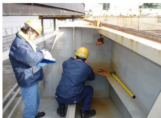
実船検認を実施している様子
