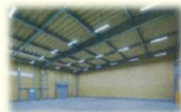
大規模流通に対応した保管施設
