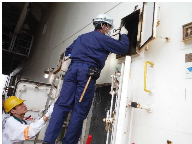
排気用のダクト内部の検査
