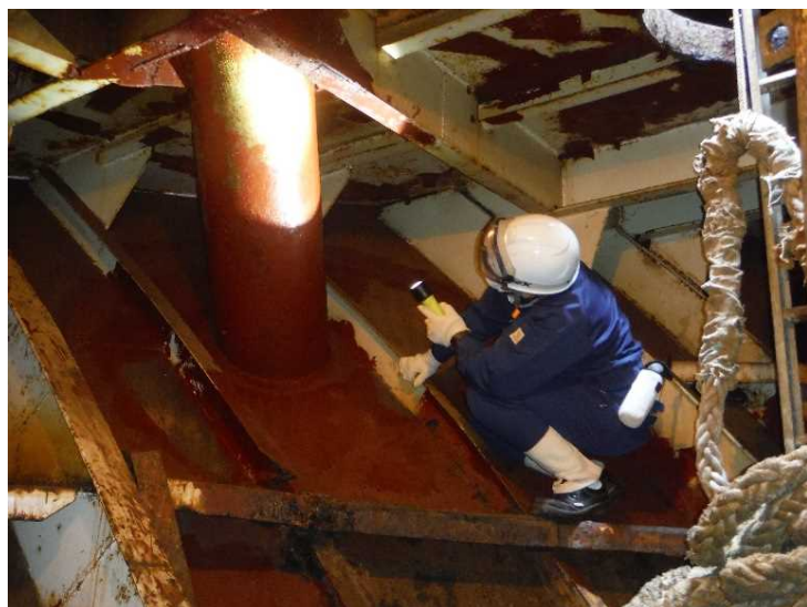
錨鎖孔(ホースパイプ)の検査
