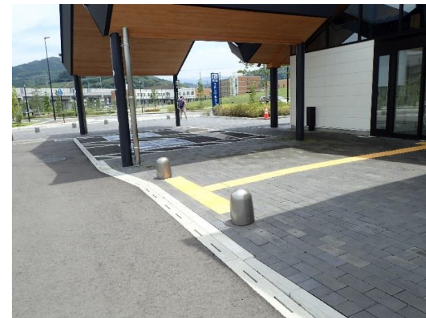
安全対策（バリカー） （「道の駅」うれしの まるく）
