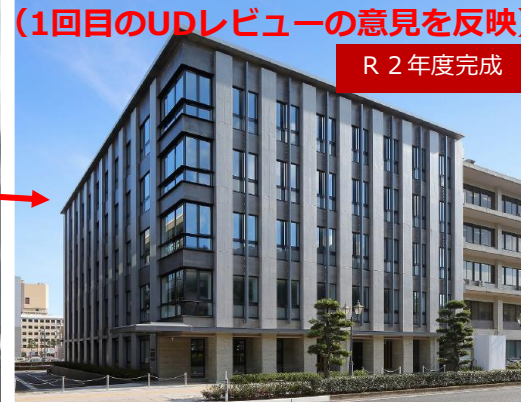
1期工事庁舎にて現地確認を実施
