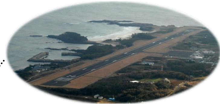
壱岐空港 設置管理者: 長崎県 滑走路: 1,200×30 供用開始: S41.7.10 運用時間: 8:00～19:00
