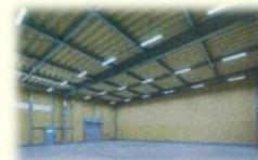
大規模流通に対応した保管施設
