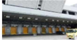
卸売市場施設・ストックポイントの整備
