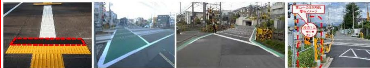
ゴムチップ舗装 カラー舗装 踏切道内の車道外側線 注意喚起看板
