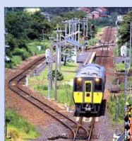
行き違い設備改良
