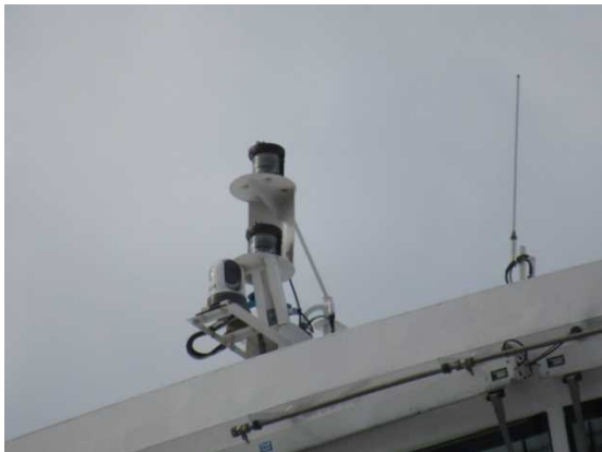
外観（灯火類）の検査
