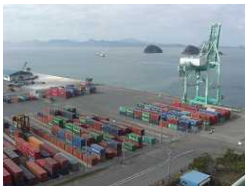
八代港コンテナターミナルと蔵置状況
