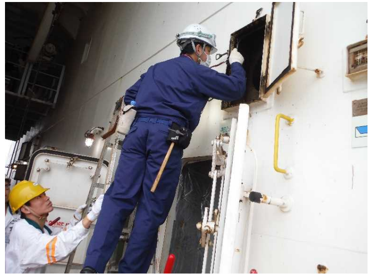
排気用のダクト内部の検査
