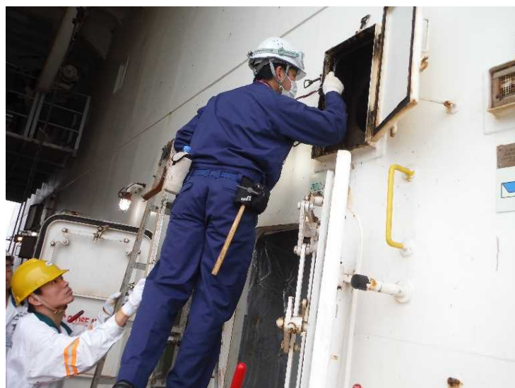
排気用のダクト内部の検査
