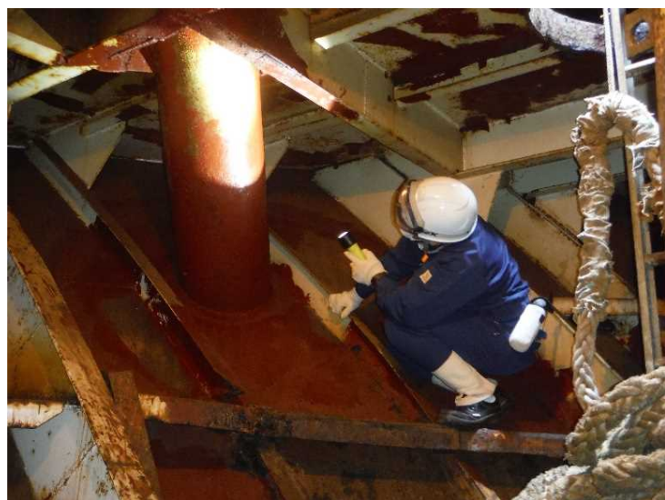
錨鎖孔(ホースパイプ)の検査
