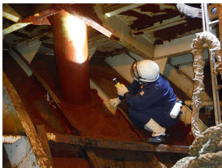
錨鎖孔（ホースパイプ）の検査
