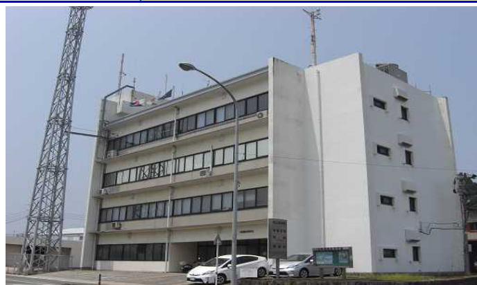
三角庁舎外観（宇城市 三角港湾合同庁舎3F）
