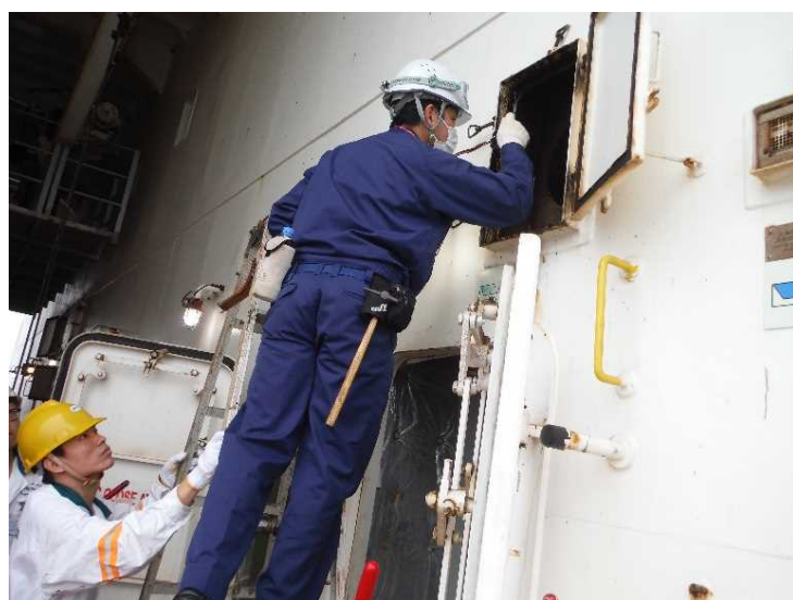
排気用のダクト内部の検査
