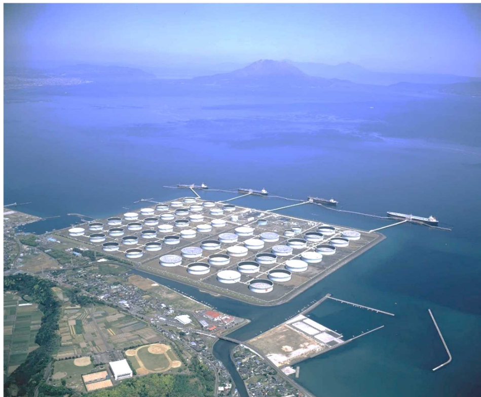
735 万キロリットルの原油貯油能力を有する「ENEOS 喜入基地」。中東をはじめとする産油国から 30 万DW級の大型タンカーで輸送されてくる原油を一旦荷揚げし、10 万DW級のタンカーに積み替えて他の製油所へ二次輸送する中継機能を有している。(写真提供:ENEOS 喜入基地株式会社)
