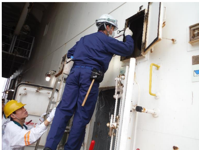
排気用のダクト内部の検査
