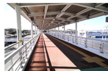
新ターミナル内には、広々とした多目的トイレも設置されている。（写真：上） ターミナルから第4パースへ向かう連絡通路。（写真：下）
