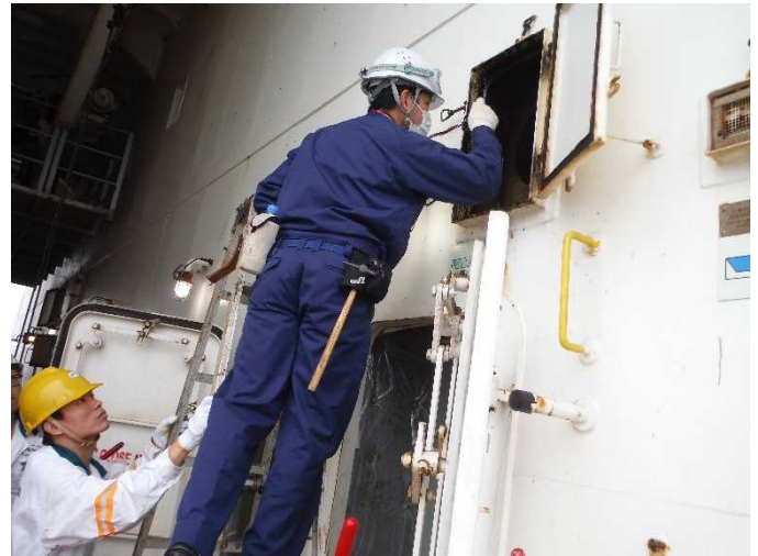
排気用のダクト内部の検査
