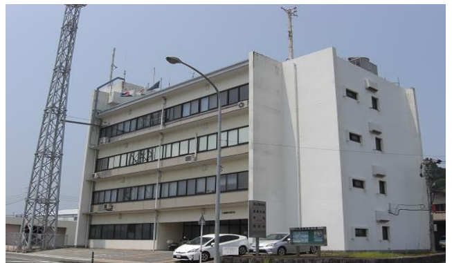
三角庁舎外観 (宇城市 三角港湾合同庁舎 3 F)
