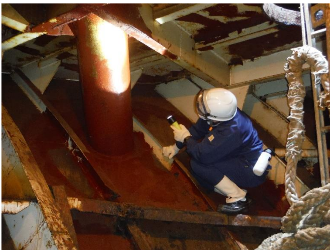
錨鎖孔(ホースパイプ)の検査
