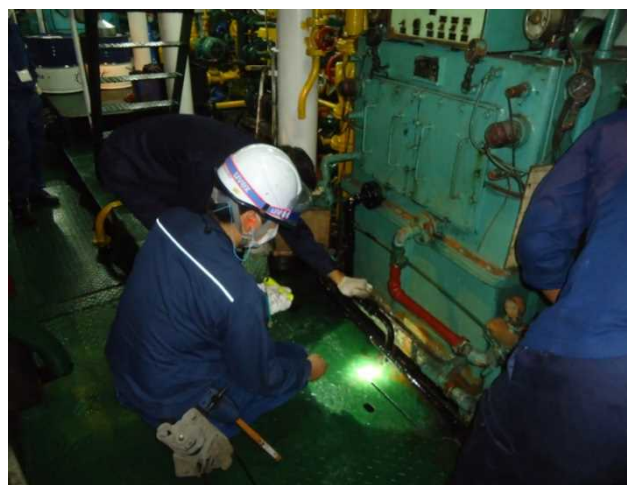
船内巡視（機関室）
