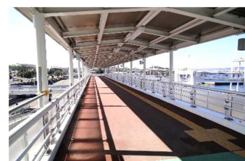
新ターミナル内には、広々とした多目的トイレも設置されている。（写真：上）
