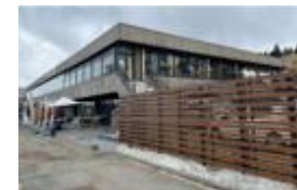
施設の外構修景14
