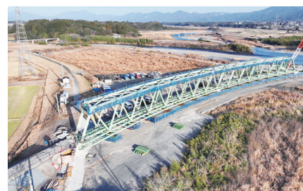
復旧中の球磨川第四橋梁(くま川鉄道)
