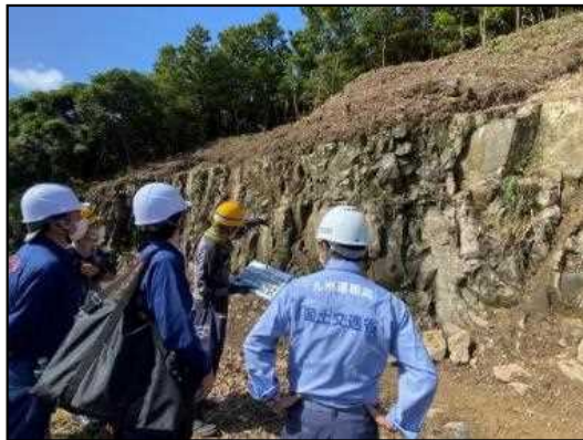
【現地での被害状況確認】
