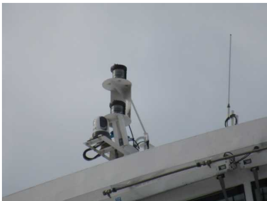
外観（灯火類）の検査
