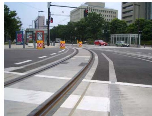
制振軌道の整備
