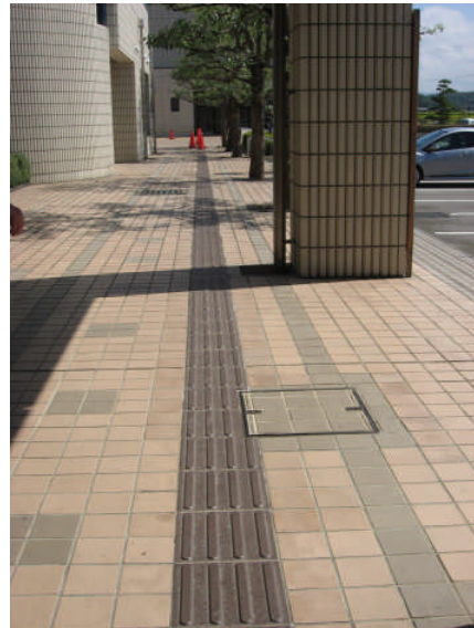
庁舎からセンターへの点字ブロック
