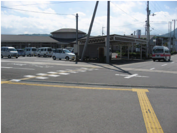
支所前道路から庁舎への点字ブロック
