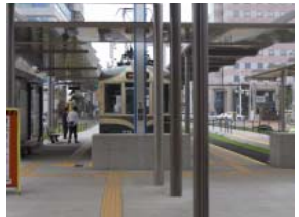
高知駅前電停(JR高知駅側から)
