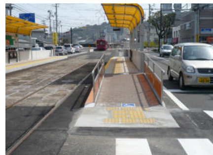
栈橋車庫前電停:スロープ
