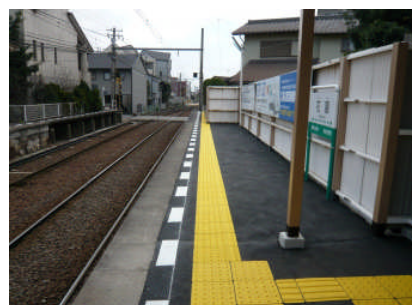
花園駅:ホームの誘導用ブロック
