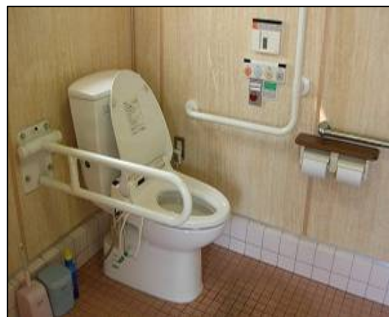
多目的トイレ
