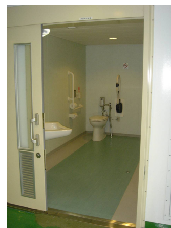
身体障害者用トイレ
