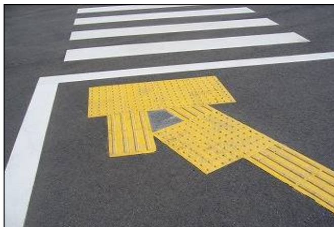
紛らわしい誘導ブロックの施工例
