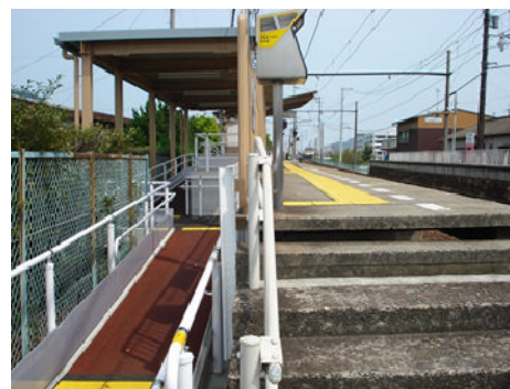
高松琴平電気鉄道(株)春日川駅スロープ
