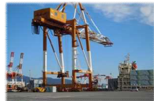
ガントリークレーン
