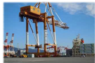
ガントリークレーン
