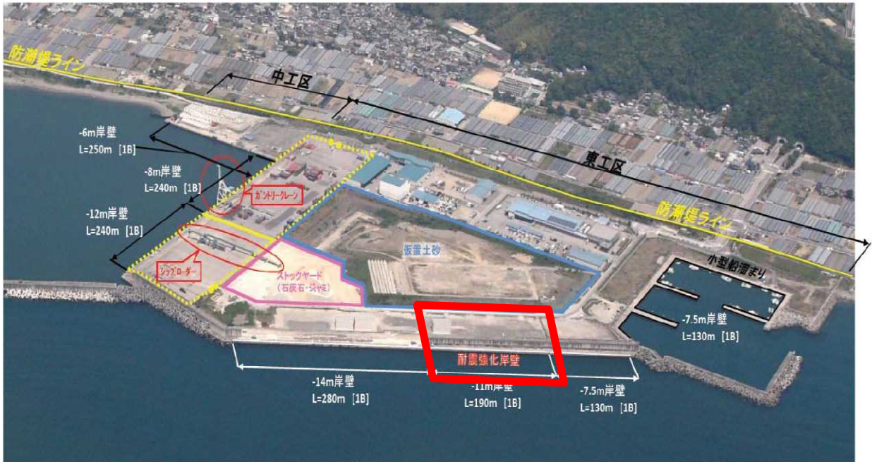
図表 3-2 高知港三里岸壁
