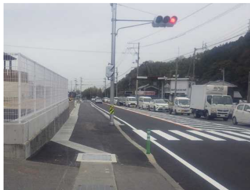
改良後の状況
