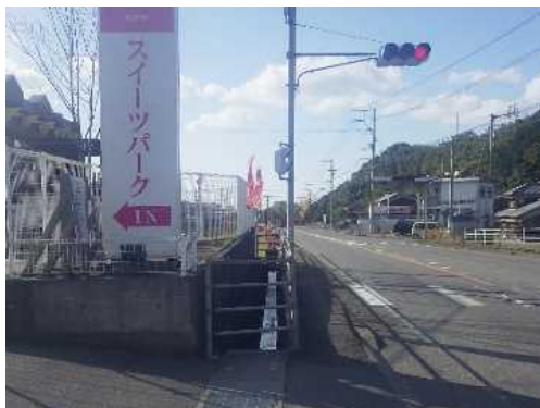
既設歩道の状況
