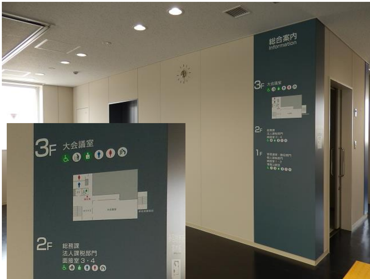
←ホールの「多目的便所案内板」
