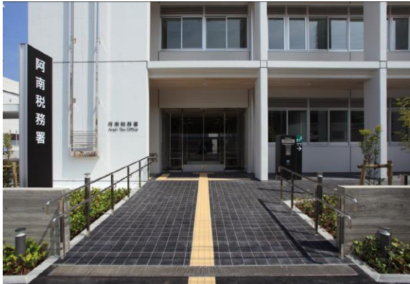
段差の無い敷地内アプローチ (手すり、点字表示の設置)
