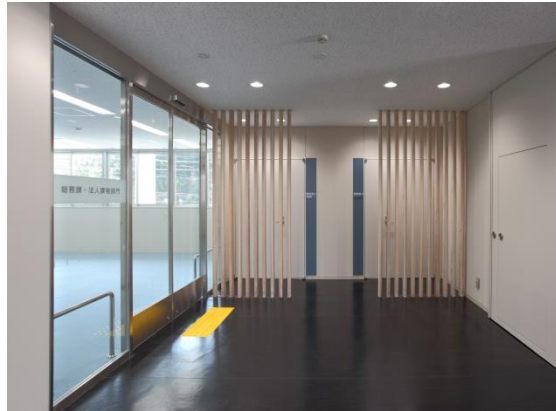
事務室出入口の自動扉化
