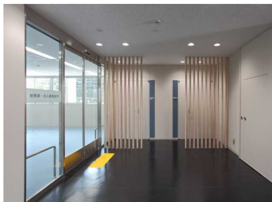
事務室出入口の自動扉化
