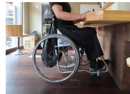
ローカウンターの設置
