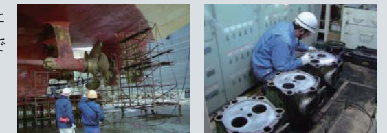
船体とプロペラの外観検査
