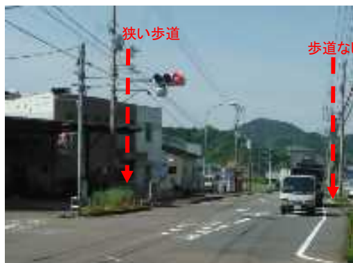
既設歩道の状況
