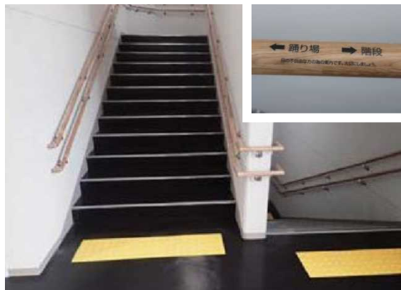
階段室(手摺、点字表示)
