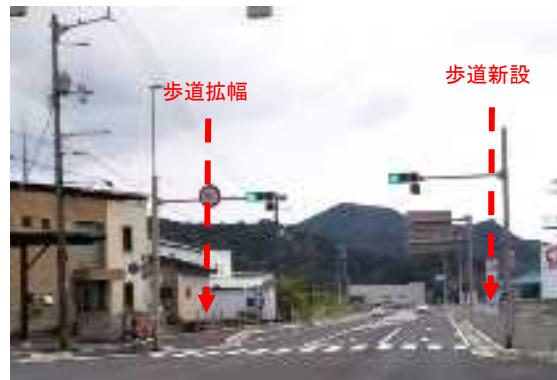
改良後の状況
